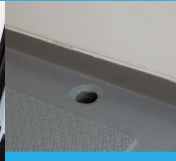
Detalle del desagüe situado en la parte delantera derecha dentro del canal perimetral
